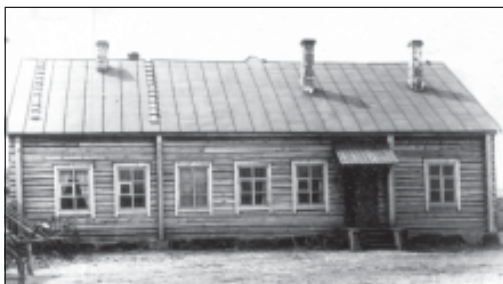
Усть-Таркская контора связи
