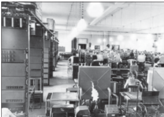
Общий вид магистральной секции
