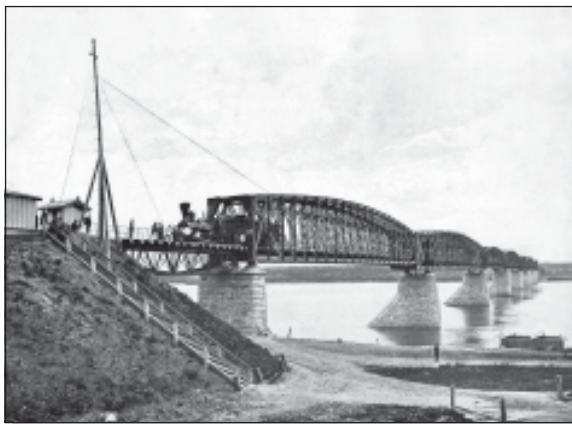
Строительство железнодорожного моста в Новониколаевске
